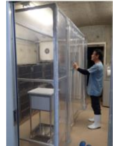
鳥インフルエンザ発生に備えた陰圧ブースの設置
