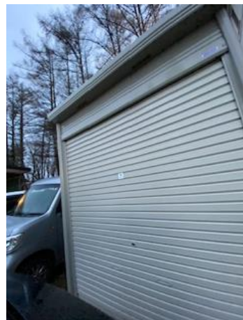
新設された除雪機の保管小屋
